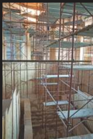
Lucrări de renovare în Corpul central al MNAR
