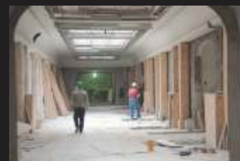
Lucrări de consolidare în Corpul central al MNAR
