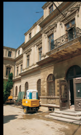
Lucrări de consolidare la Muzeul Colecțiilor de Artă
