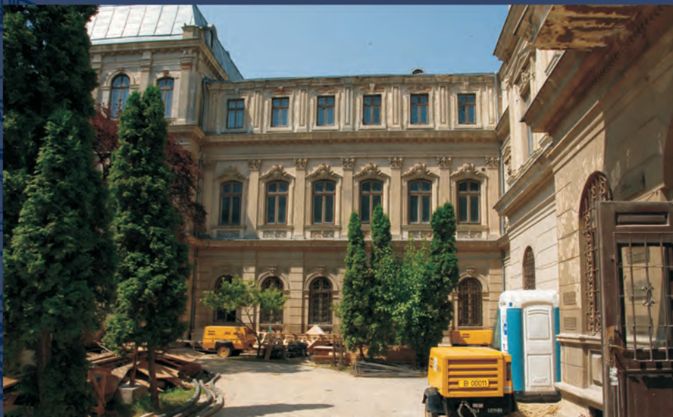
Lucrări de consolidare la Muzeul Colecțiilor de Artă
